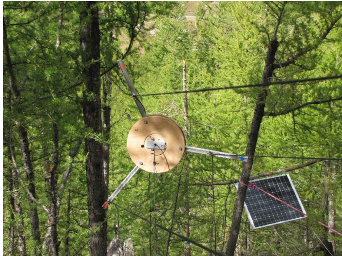
Nouveau tetras Obelix pour reprise de tension des 3 câbles Sud, panneau solaire
